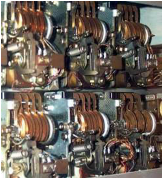
Fig. Selectores de control-marcadores 7D
